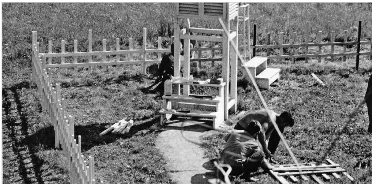
Obr. 5 Stavba meteorologické zahrádky
