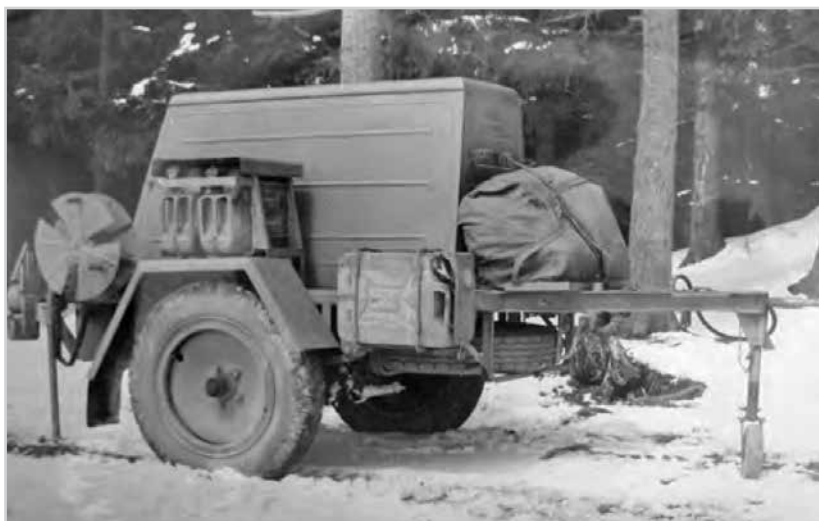
Obr. 6 Elektrocentrála EC 7,5 kVa v soupravě LPS-65
