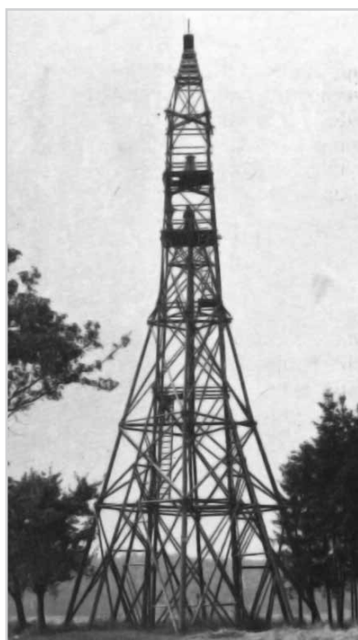
Obr. 15 Stavba měřické věže s vestavěným stanovištěm
