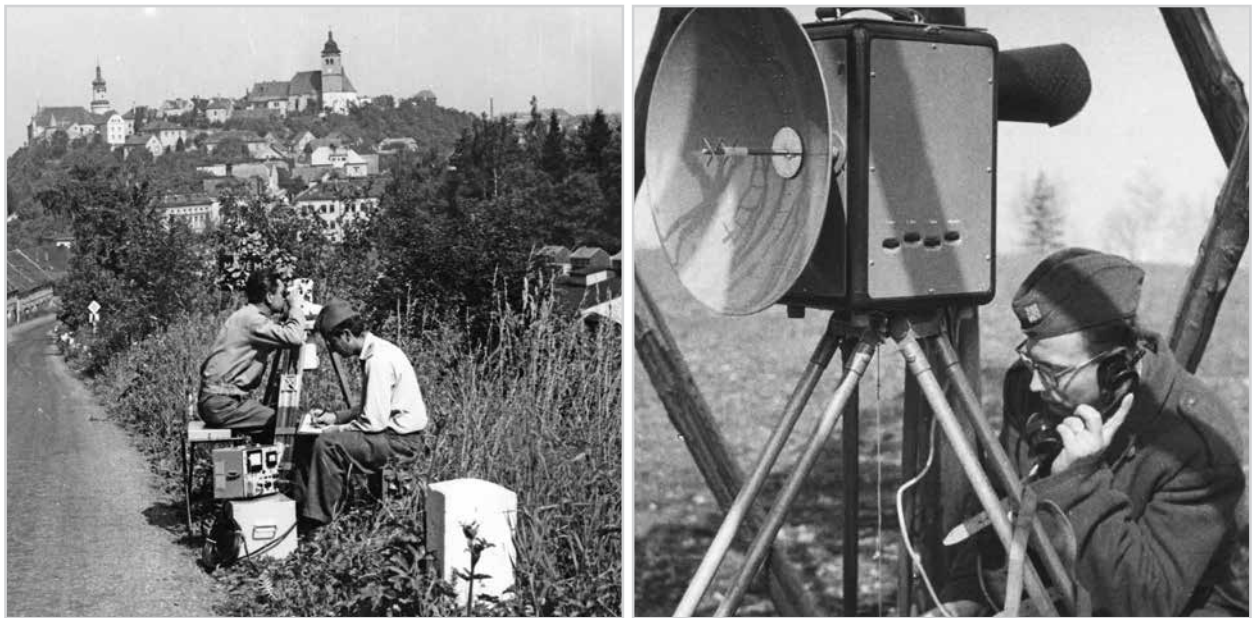
Obr. 9 Měřické práce s gyroteodolitem Gi-B1/E (vlevo) a radiovým dálkoměrem Tellurometer MRA 1 (vpravo)
