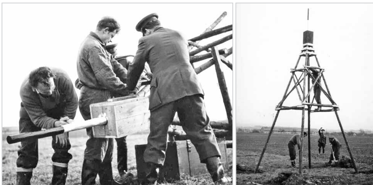
Obr. 7 Údržba orientačních zařízení na bodech ČSTS
