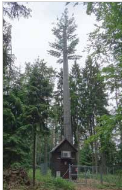
Obr. 2 Telekomunikační věž – Telecommunication Tower
