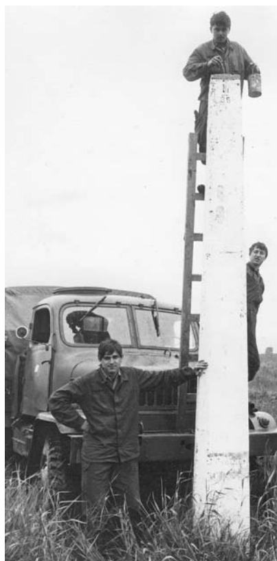
Obr. 21 Údržba hraničního kamene na dně vypuštěné Oravské přehrady (Slovensko)
