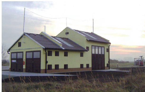
Obr. 21 Nové provozní prostory v Prostějově
