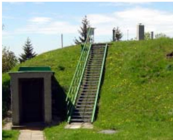
Objekt hraničního opevnění
