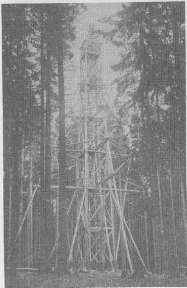
Obr. 6. Měřická věž v kopcovitém, zalesněném území Českomoravské vrchoviny. Trigonometrický bod Žákova hora – červenec 1924
