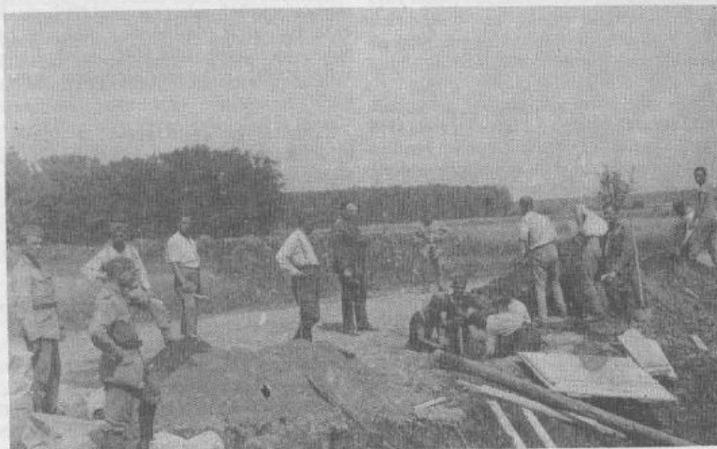
Obr. 3. Stabilizace jižního konce základny u Mukačeva – rok 1928 (při silnici Mukačevo–Berehovo)
