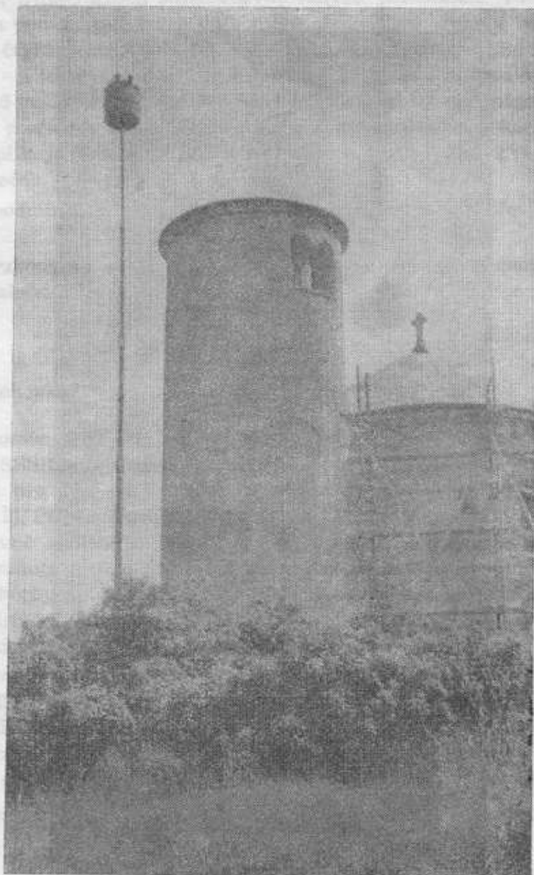
Obr. 2. Korba vysunutá do výše 20 m vedle rotundy na Řípu
