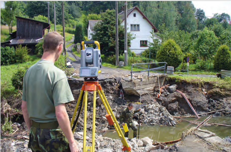
Obr. 33 Provádění geodetických prací pro výstavbu mostních provizorií po povodni
