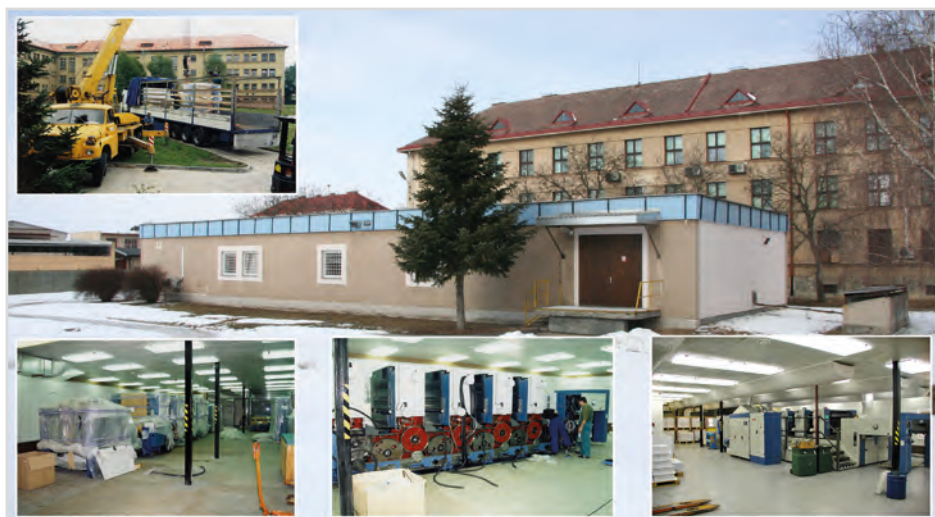
Obr. 26 Záběry z montáže tiskového stroje RAPIDA 105 v nově upravených prostorech polygrafického pracoviště VTOPÚ v Dobrušce
