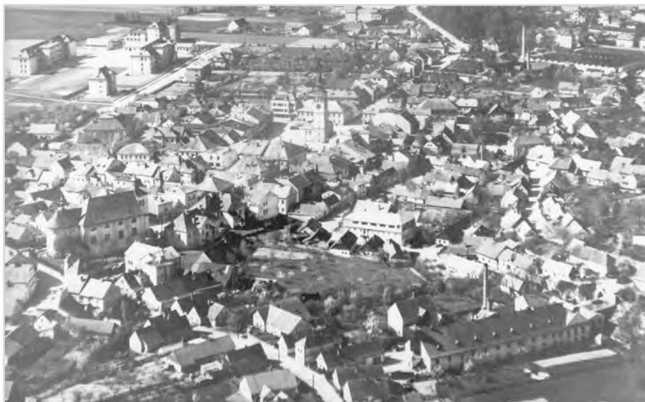
Obr. 9 Část města a dobrušské kasárny (vlevo nahoře) v době vzniku 2. VZÚ Dobruška
