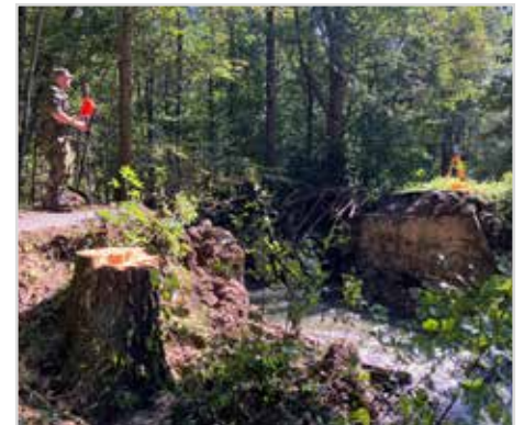
Obr. 8 Vojenští geodeti se pravidelně podílí na výstavbě mostních provizorií
