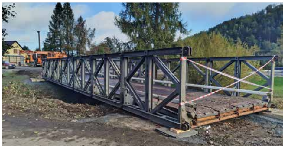
Obr. 11 Mostní provizorium položené na místě původního přemostění
