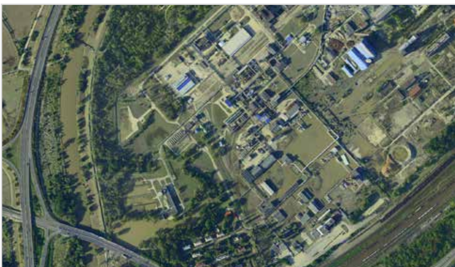
Obr. 1 Řekou Odrou zaplavená část lokality Ostrava – Mariánské hory
